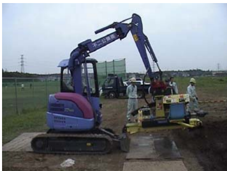
フレックスドリス接続状況
