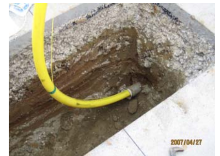
配管引抜き状況
