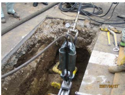
トリックトレンチレス設置状況
