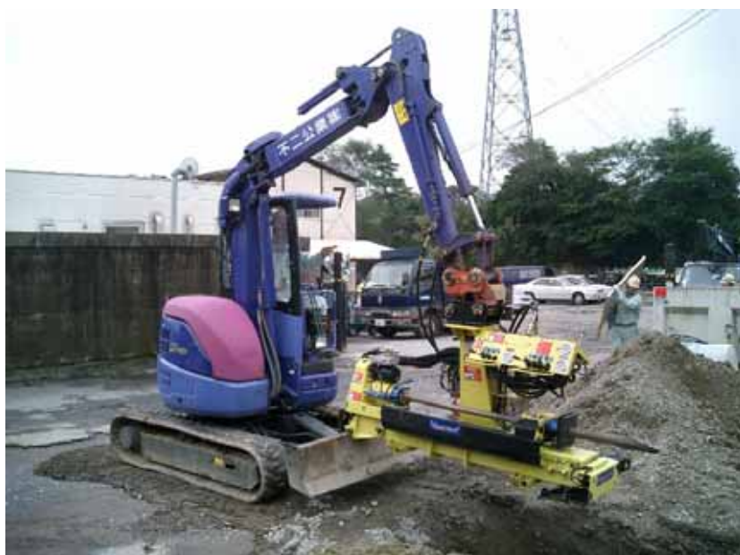
黄色部分が推進機。掘削機の油圧を利用してコンパクト化をはかれ、狭い場所でも施工が可能
