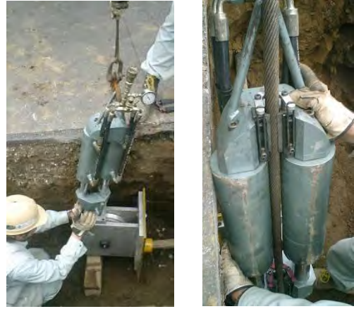
写真8. ワイヤー引き込み機械本体設置
