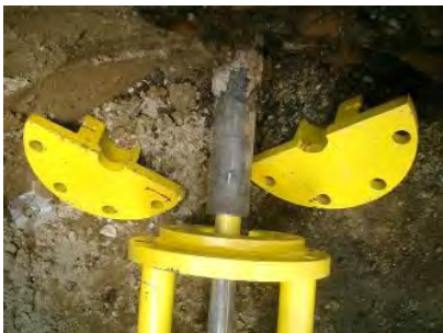
写真 16. 円形対応部材取り外し
