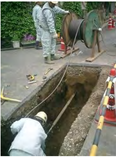
写真6. ワイヤー挿入作業
