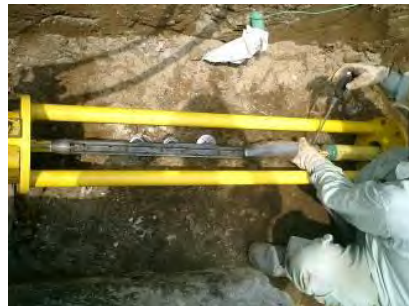
写真 19. カッター取り外し
