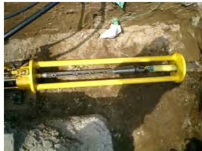
写真 18. カッター引き込み完了
