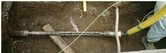
写真7. カッターとポリエチレン管の接続
