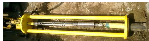
写真 13. カッターが納まる空間
