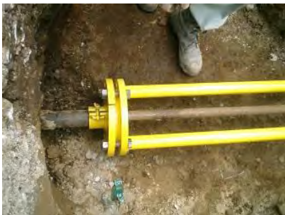
写真 15. 拡径前（円形）の状況
