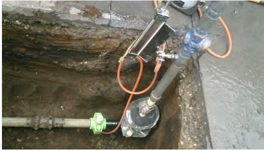
写真5. バイパス管設置状況
