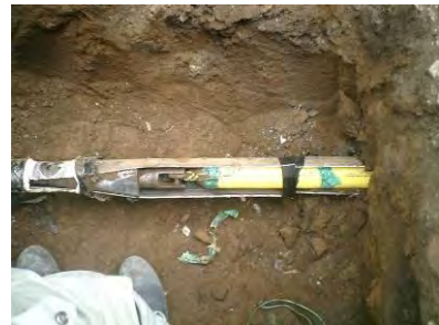
写真10. 新設管引き込み状況
