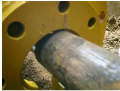
写真 17. 拡径断面对応状況
