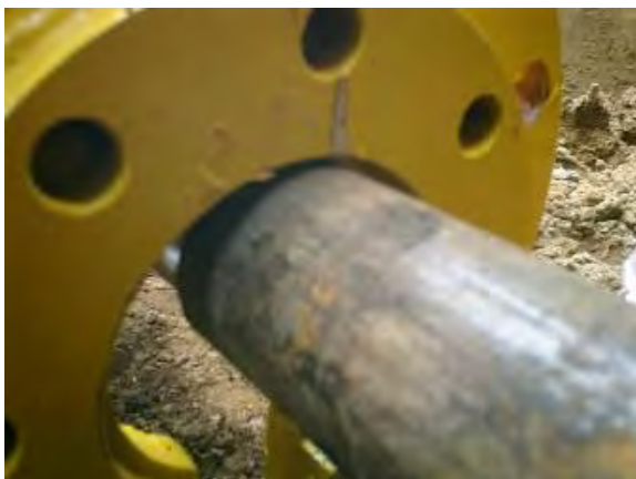
写真-16 拡径断面对応状況
