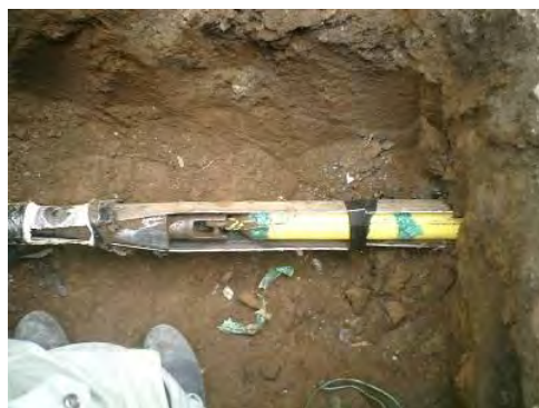
写真-9 PE管引入状況
