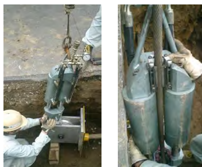
写真-7 本体設置状況
