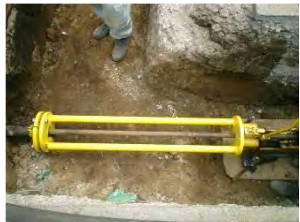
写真-13 回収治具設置
