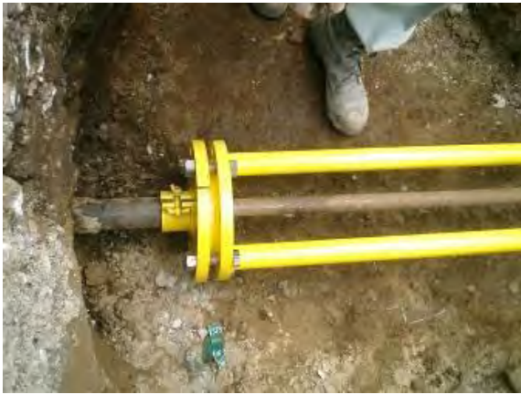
写真-14 拡径前(円形)の状況
