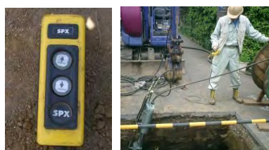
写真-2 リモコン作業
