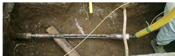
写真-6 カッター設置状況
