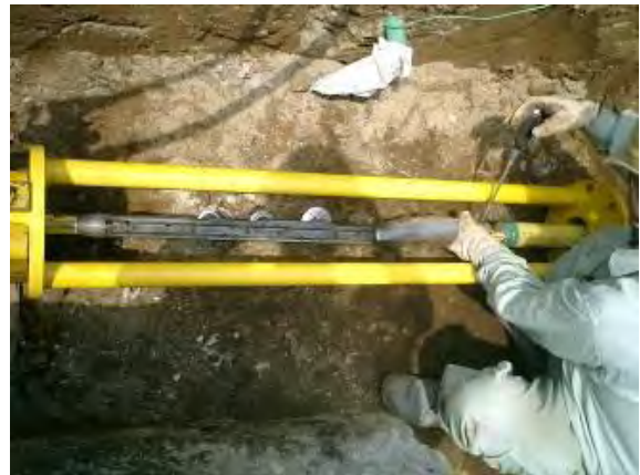
写真-18 カッター取り外し
