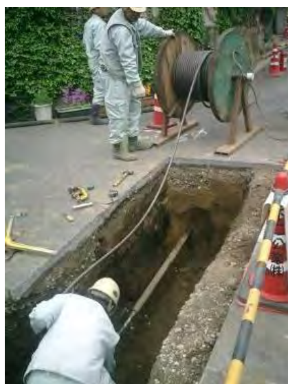
写真-5 ワイヤー挿入状況
