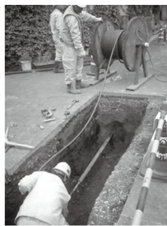
「ワイヤーの挿入作業」作業員の負担軽減と作業時間の短縮がはかられた
