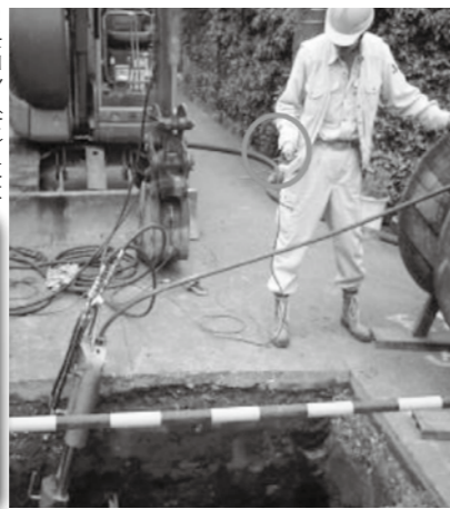
リモコン（下）による地上からの操作で安全性が向上
